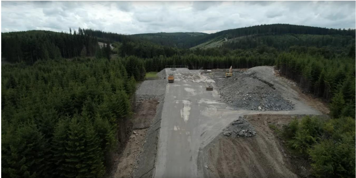
Bild 8: Geländeenivellierung für ein Windkraftwerk von 3,45 MW 31
