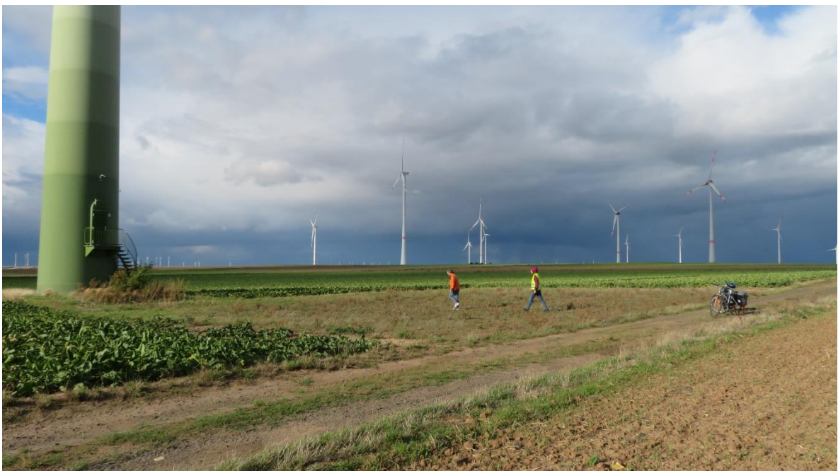
Bild 34: Windkraftwerke bei Biedesheim/Pfalz
