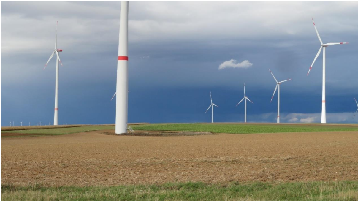
Bild 41: Windkraftwerke bei Biedesheim/Pfalz
